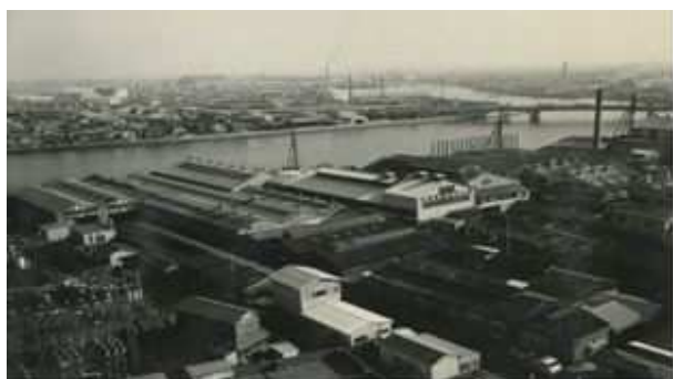
写真：1960 年代隅田川沿い神谷橋付近の工場群
