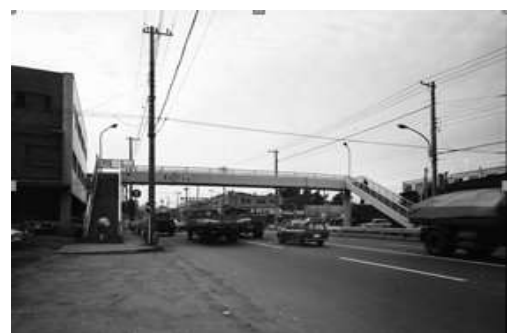
北区で最初に架けられた環状7号線の神谷歩道橋（1970年頃 北区撮影）
