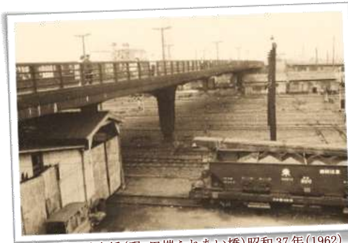
【写真】田端大橋(現、田端ふれあい橋)昭和37年(1962) 倉田正義氏撮影 ※橋脚の少なさをご確認ください。
