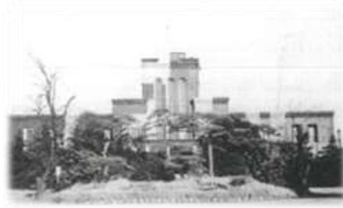
米軍により白く塗られる中央公園文化センター
