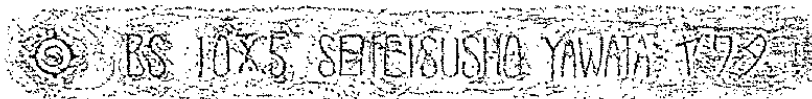
八幡製鉄所の刻印(写真はすでに解体された210号棟のもの)
