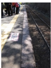
足尾の通洞駅 ホーム
