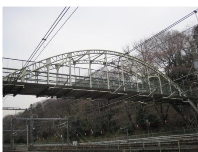
写真2 飛鳥山下人道跨線橋
